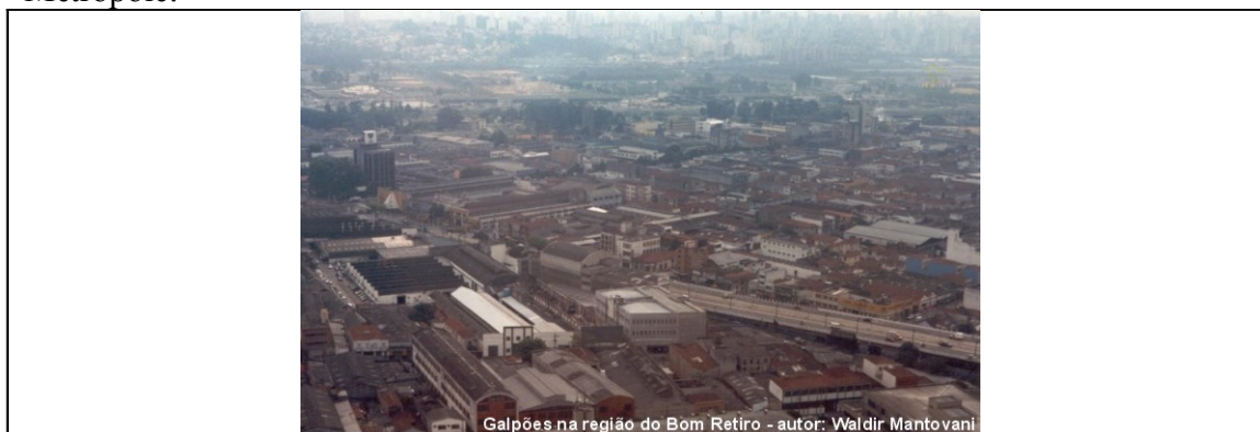
Figura 1 – Exemplos de Galpões de Fábrica Desativados nas Áreas Centrais da Metrópole.
