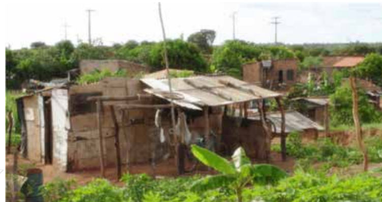
Figura 25 – Córrego do Machado
