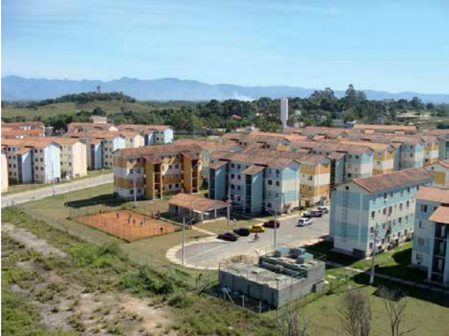
Figura 1: Empreendimentos PMCMV Estrada dos Palmares
