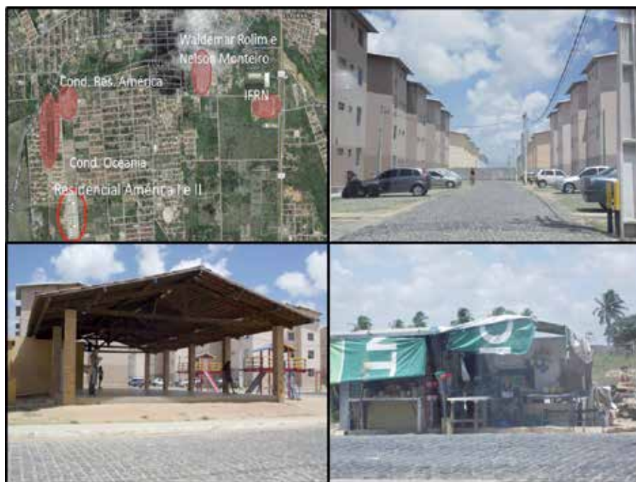
Figura 7: Registro Fotográfico do Empreendimento América II e entorno.
