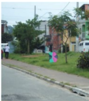
2 canalização do córrego sob canteiro central subutilizado
