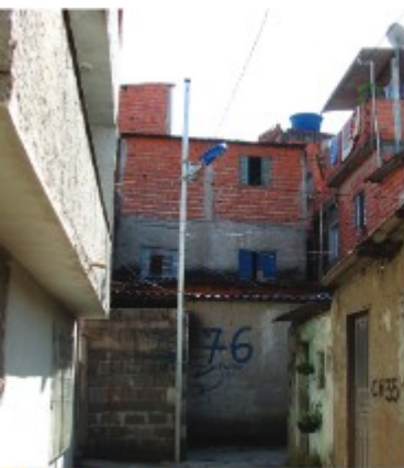
1 descaracterização de nascente, ocupação desordenada com vielas
