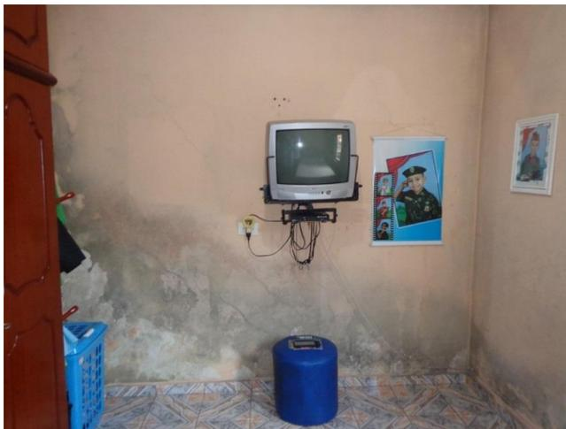
Infiltrações de laje, telhado e solo.
