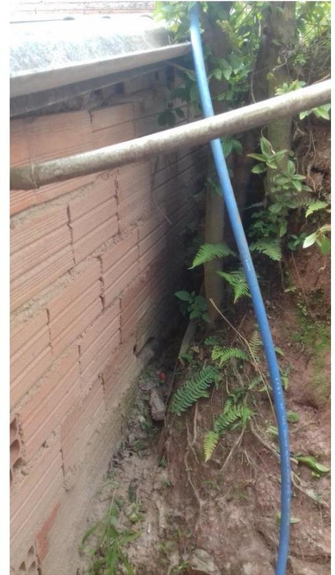
Parede com umidade proveniente do solo. Fonte: SHDU/PMD.
