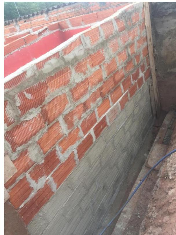
Implantação de drenagem e construção de nova parede impermeabilizada. Fonte: SHDU/PMD.
