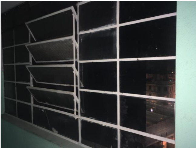
FOTO 11.1 Instalação de vidro nos basculantes
