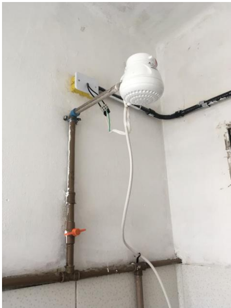
FOTO 7.1 Instalação de conector para fiação
