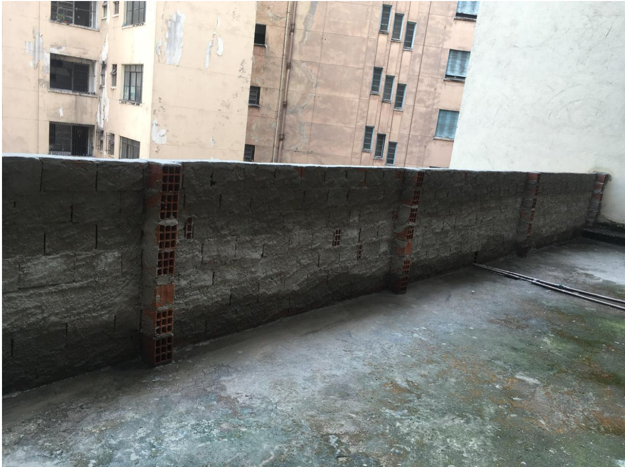
FOTO 14.1. Parapeito em alvenaria, construída na laje da lavanderia
