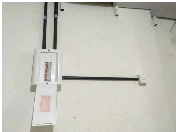
FOTO 5.1 Fiação organizada em eletrodutos e quadro de luz
