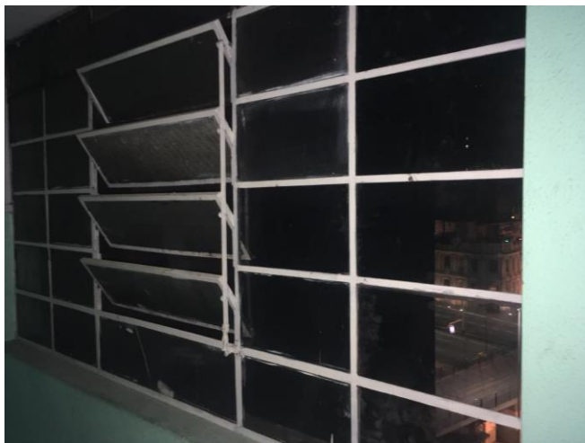
FOTO 11.1 Instalação de vidro nos basculantes
