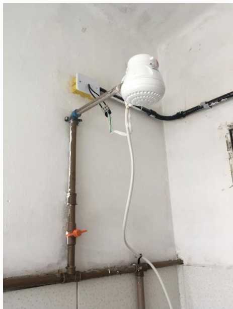
FOTO 7.1 Instalação de conector para fiação
