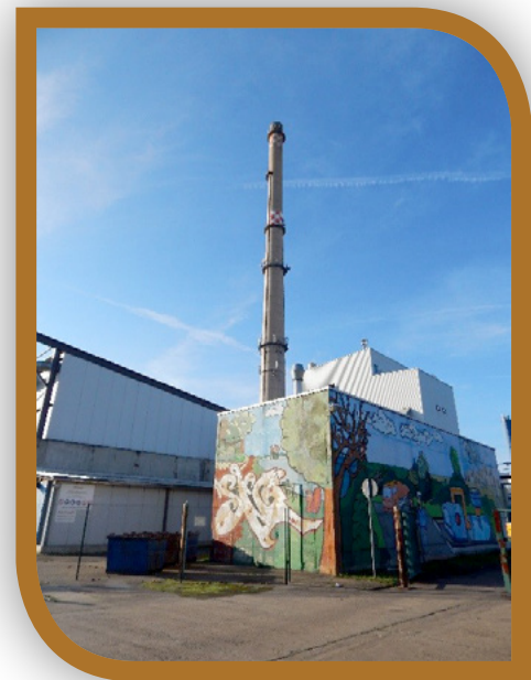
Planta de Incineração na Alemanha (acervo MMA)
