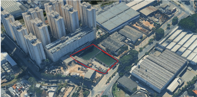
Bairro Canhema Terreno não edificado na Av. Dr. Ulysses Guimarães, hoje identificado como Arena Biro Biro
