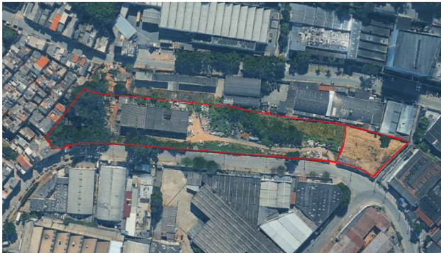
Bairro Casa Grande Terreno não edificado localizado entre as Avenidas Fundibem e Presidente Costa e Silva
