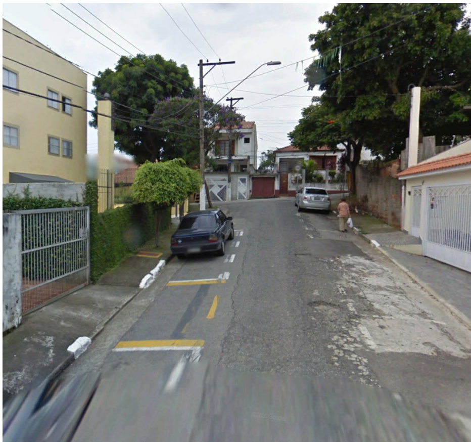
Figura 87 - Calçadas estreitas e com obstáculos na rua José de Alencar, nº 51. (imagem: Google Street View, 2025 / elaboração: UrbVerde, 2025)
