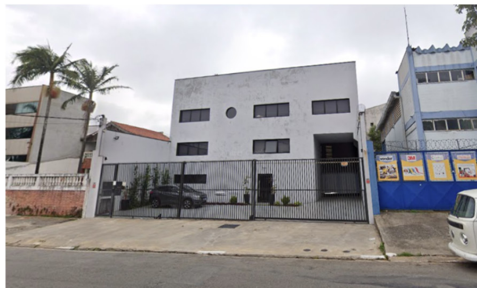
Edificação para uso industrial ou comercial Av. Dom Pedro I – Bairro Conceição
