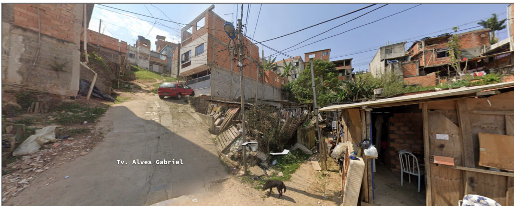
Figura 52 - Exemplo de urbanização recente com características de autoconstrução de baixa renda e ausência de infraestruturas em terreno irregular no Sítio Joaninha, Eldorado (imagem: Google Maps e Google Street View, 2025 / elaboração: UrbVerde, 2025)
